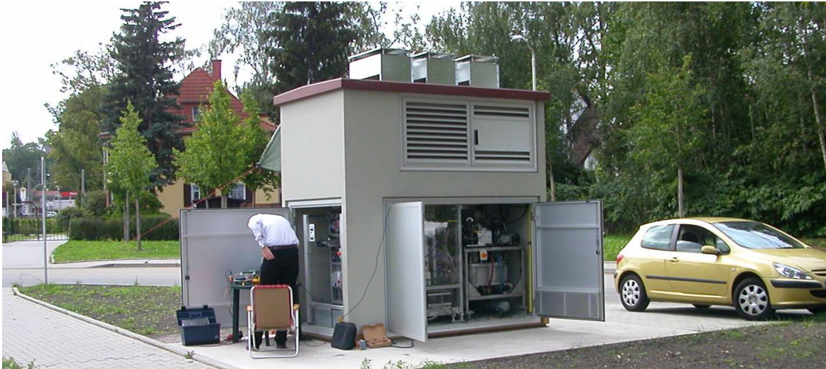
Abbildung 4 : Schwungradspeicher am Bahnnetz Zwickau während der Inbetriebnahme
